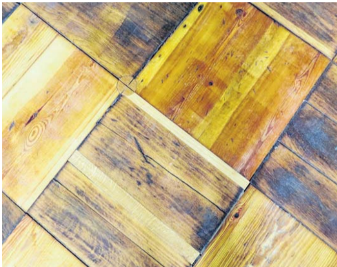
Begehbare Geschichte: Die Schönheit des alten Holzfußbodens im jetzigen Jagdzimmer konnte wieder hergestellt werden.
